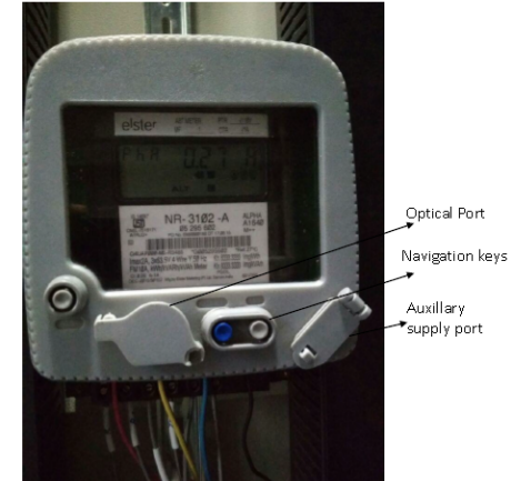
Check meter: NR-3102 A Model- Alpha M++
